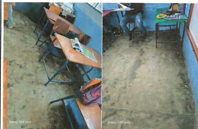
Foto 2: Aula 4 y 5 se trabajará mejoramiento e instalacion de piso cerámico.
