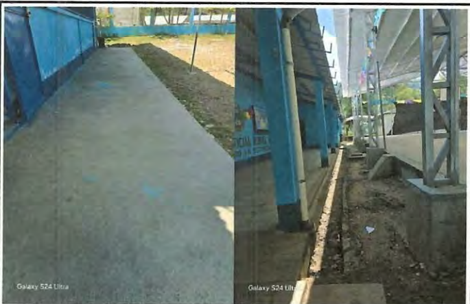
Foto 3: Corredor del aula No. 4 y 5, se trabajará mejoramiento e instalación de piso cerámico; y el espacio de tierra, se trabajará Mejoramiento de losa de patio con torta de concreto
